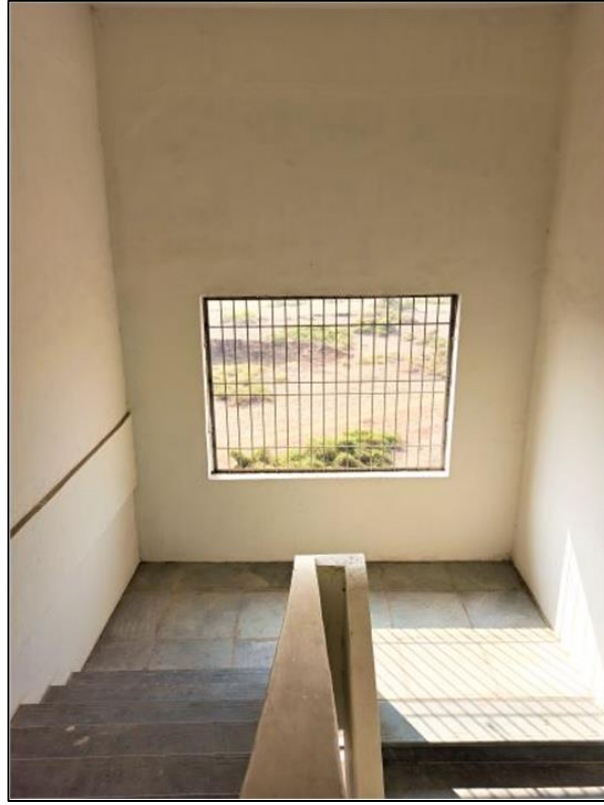
प्रथम तल पर सीढ़ी । Stair case at first floor
