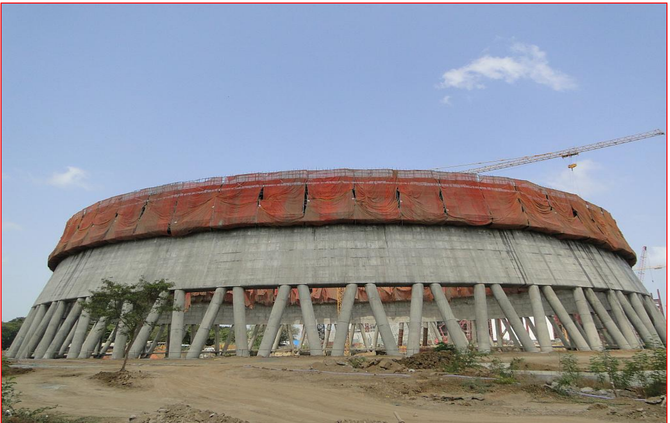
NDCT#3A construction (Jun-2016)
