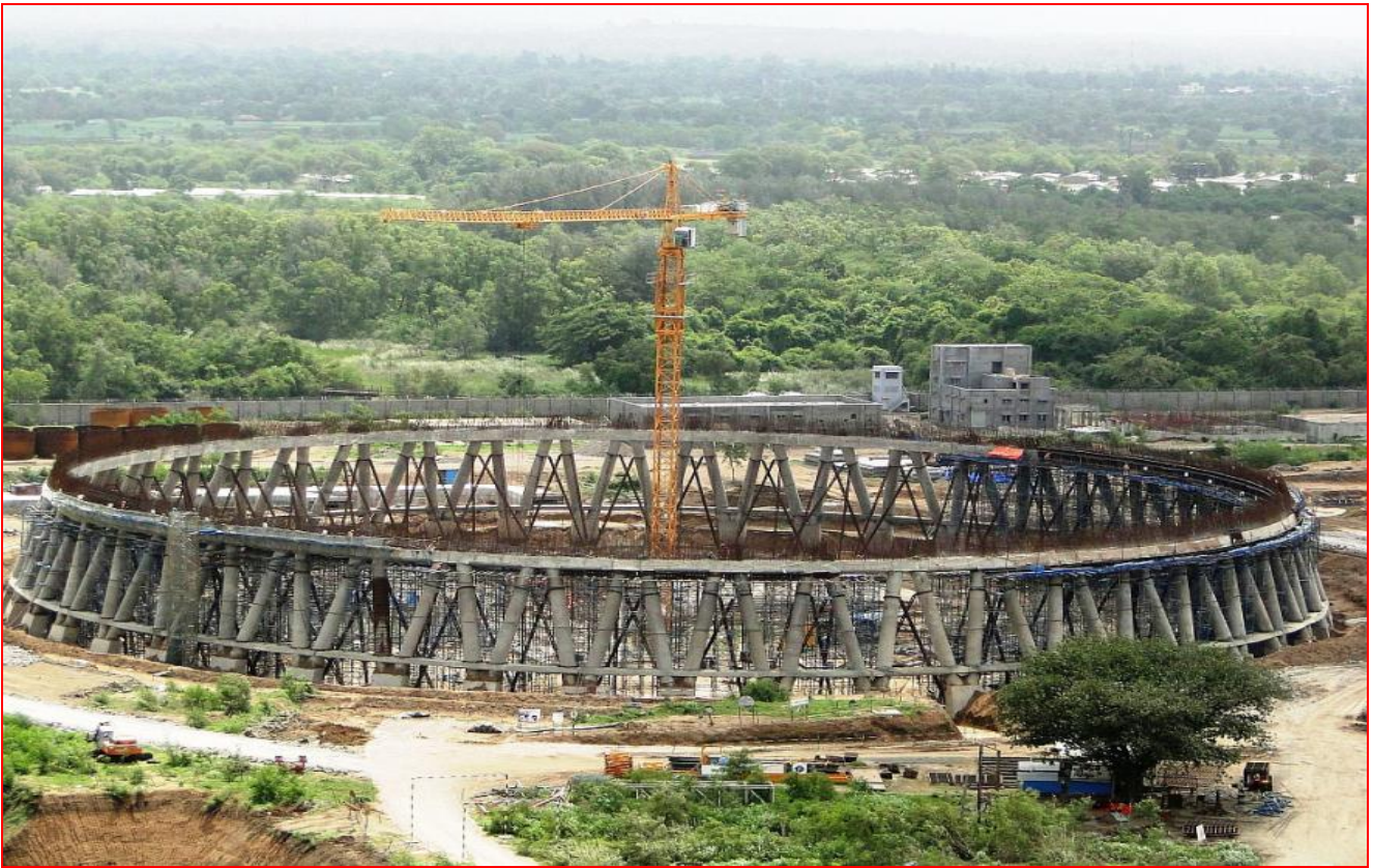
NDCT#3A construction (Jul-2015)
