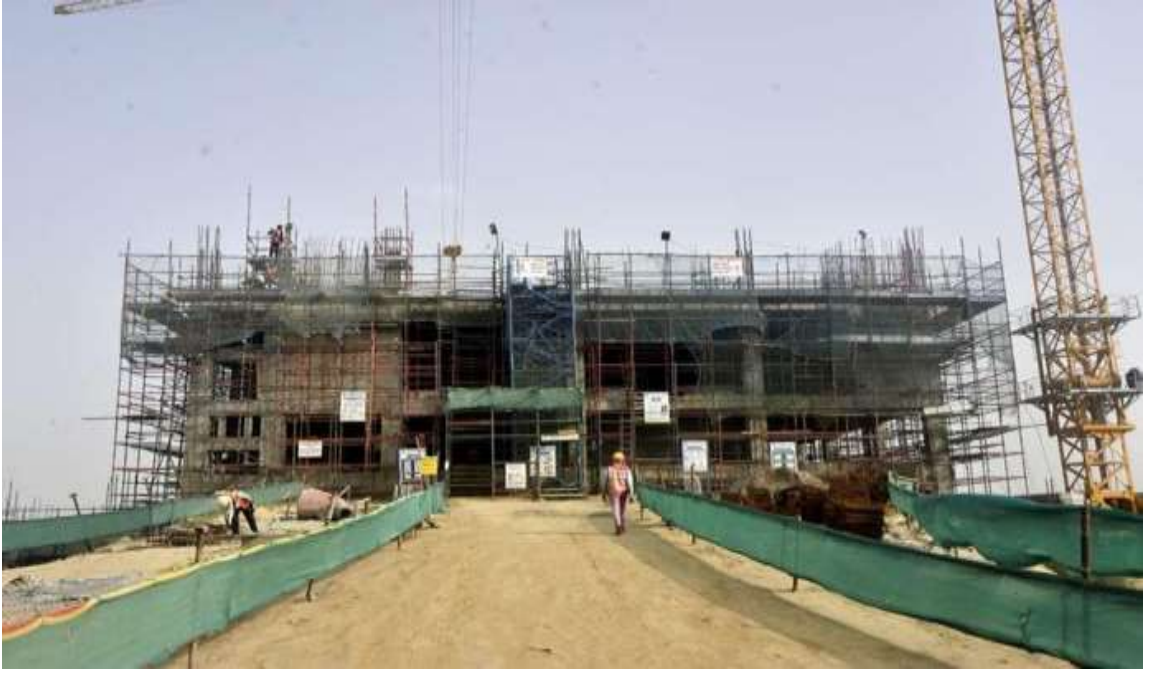
स्विचयार्ड नियंत्रण भवन का निर्माण
